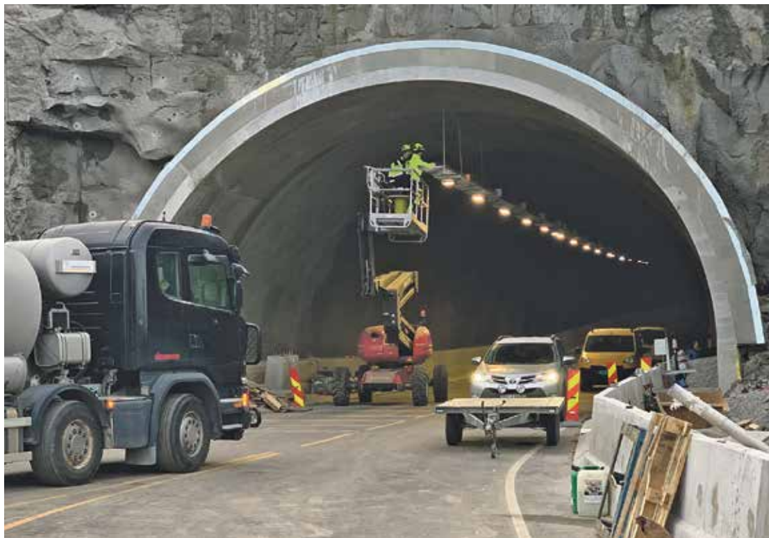
SLUTTSPURT: Montering av lys kompletterer den omfattende tekniske utrustningen i Furumotunnelen. På tross av forholdsvis liten bergoverdekning og nærhet til boliger, sykehjem og jernbane har tunnelarbeidet gått helt etter planen. Bildet viser portalen mot vest ved E6.
