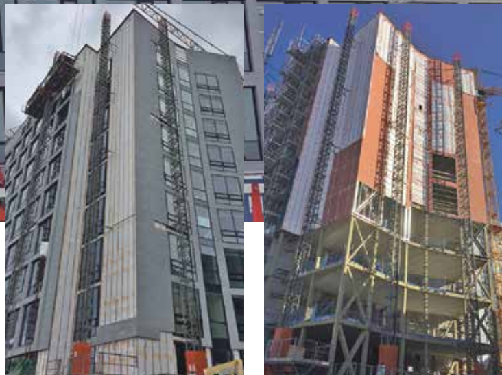
OMFATTENDE: De nye tilbyggene på hver side av AB-blokka medførte inngrep mot alle etasjer.
