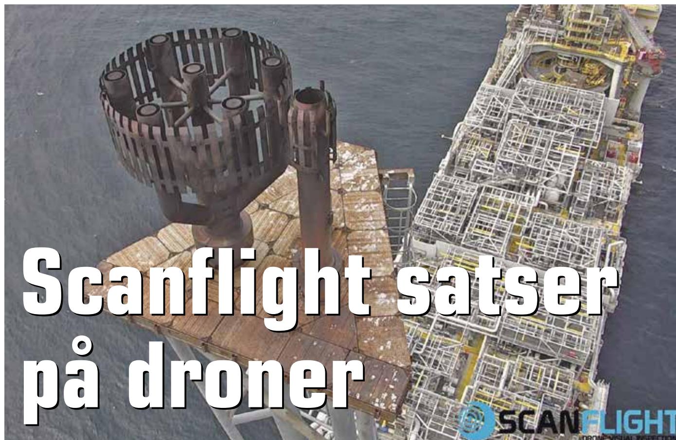
SKARV: Med bruk av drone kunne flammefårnet på Skarv-skipet inspiseres på kloss uten risiko.
