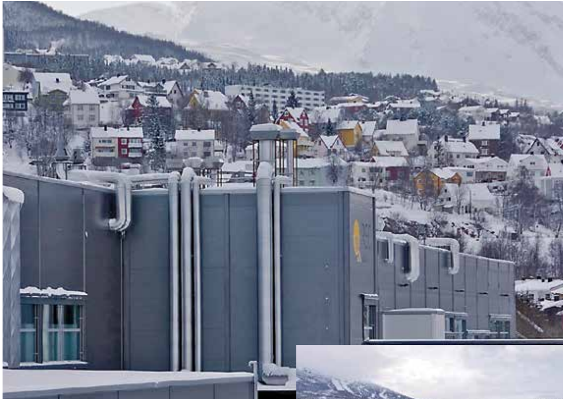
LOKALENE ETTER REC: Produksjonen av hydrogenbaserte brenselceller skal skje i bygget som tidligere huset solcellefabrikken til ScanCell REC. Foto: Siva
