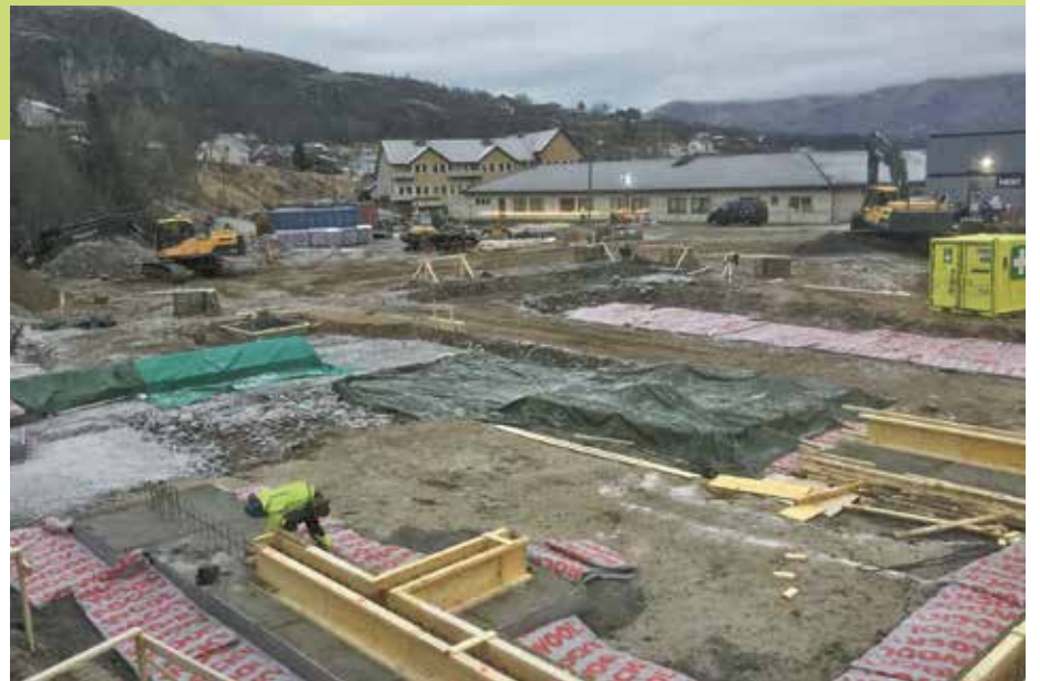
OPPSTART: Grunnarbeid og forskaling for betong startet høsten 2018. Foto: Meløy kommune.
