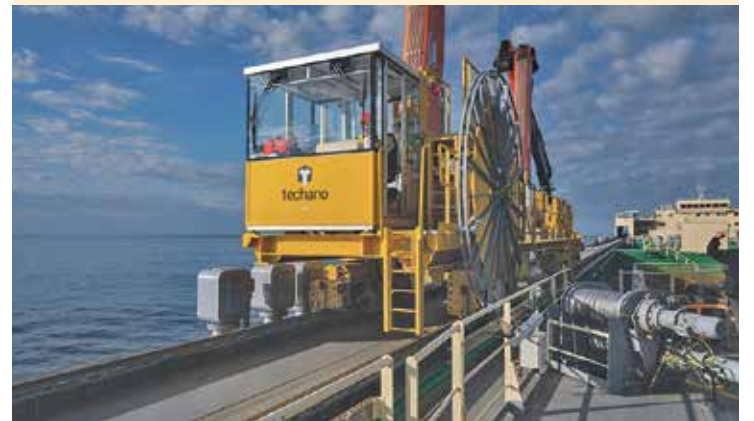
LANDSTRØM: Operasjonene utføres av skinnegående, elektriske servicevogner. Foto: Nordlaks.
