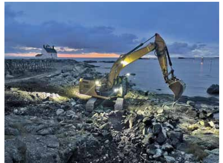
Akkurat nå er det bare grunnarbeid, men vinteren 2023 vil prøveproduksjonen være i gang hos Lofoten Biomarine AS på Værøy. Foto: Alf Brekken AS
