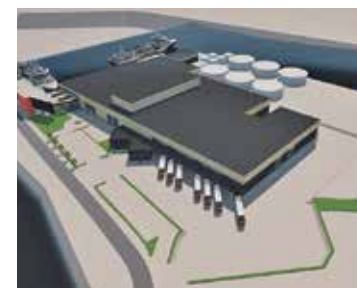
SLUSER: Her ser vi lastesluser for ferskt produkt, med tilhørende ekspedisjon og oppholdsrom for sjåfører. Parkering for ansatte vist mot nytt inngangsparti. Rundkjøring for vareleveranser. Illustrasjon: Nova Sea AS
