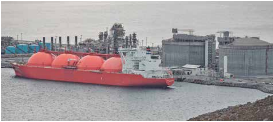
Melkøya: Elektrifisering fra land kan spare eierne av Melkøya for vel 3 milliarder kroner årlig. Foto: Ole Jørgen Bratland/Equinor
