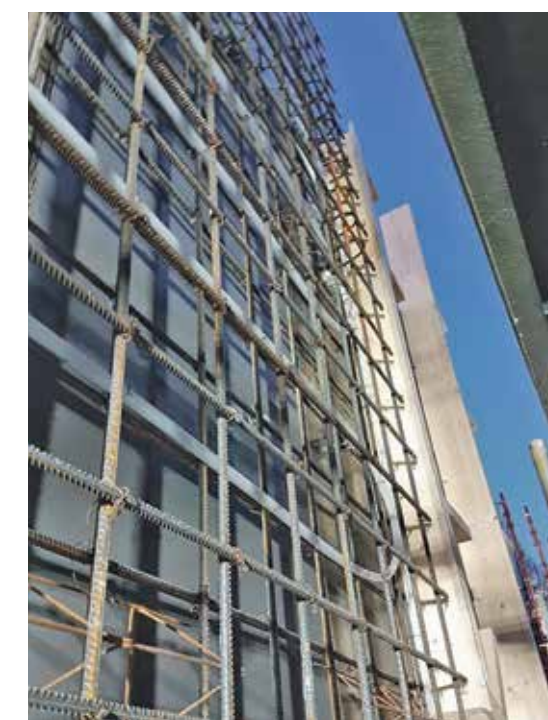
HERDING: Varmesystem fra HeatWork ble løsningen da temperaturen gikk under 20 minusgrader. Væskebåren varme sørget for jevn herding av betongen.
