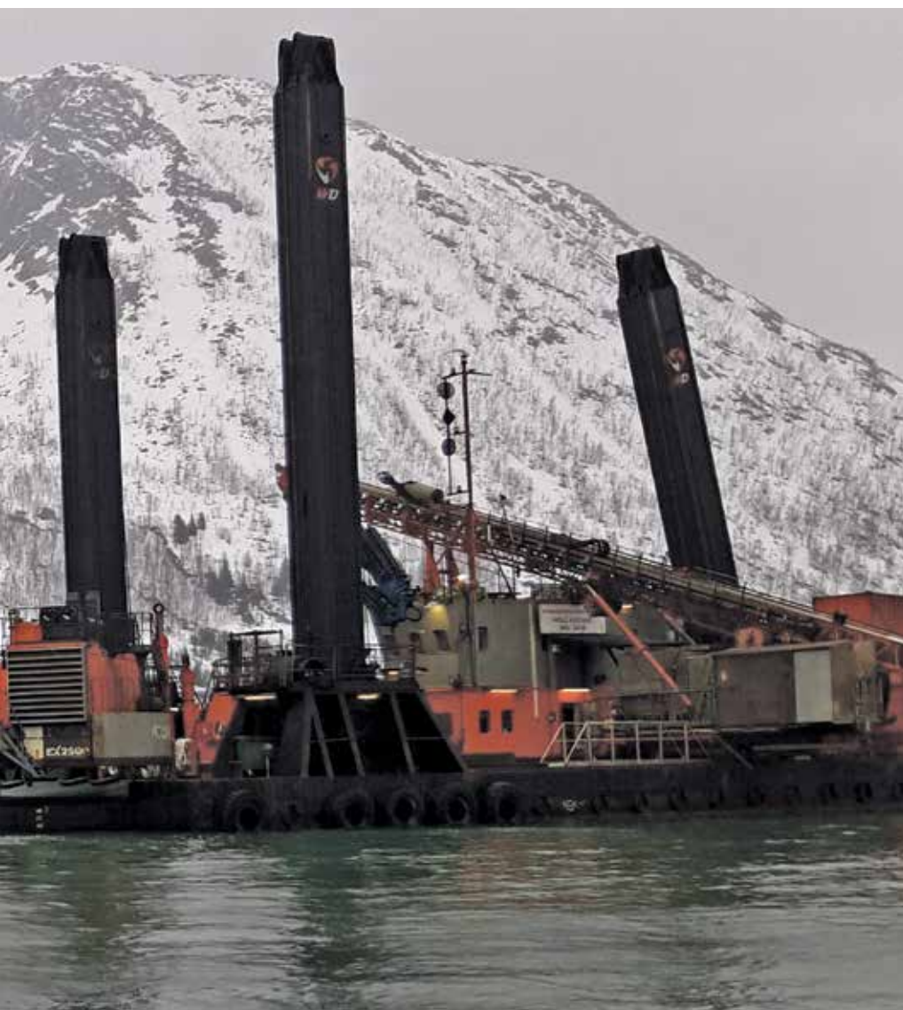
MUDRING: Både innseiling og indre havn i Senjahopen blir utdypet for å kunne ta imot større og moderne fiskefartøyer. Mudringen utføres av det finske selskapet Wasa Dredging Oy Ltd. Her er selskapets mudringsleker "Hector" i gang med å hente opp masser fra havbunnen. Foto: Martin Dreyer Ingebrigtsen - Senja kommune
