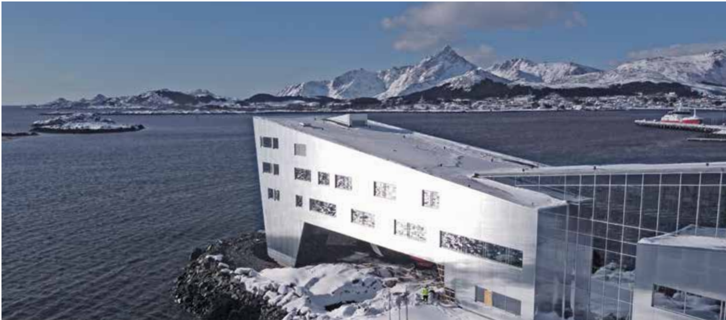
BLANK ELEGANSE: Kombinasjonen av store glassflater og fasadeplater av aluminium får Stim-bygget til å glitre mot snødekte omgivelser. Foto: Øksnes Entreprenør AS.
