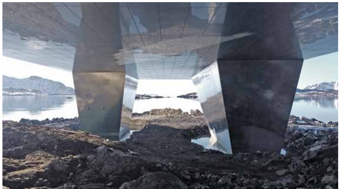
SPESIELL KONSTRUKSJON: Sjø-fløya hviler på fire føtter, noe som bidrar til byggets spesielle uttrykk. Foto: Øksnes Entreprenør AS
