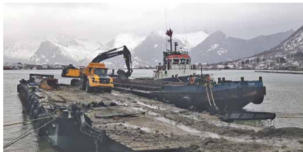
LOSSING: Maskinentreprenøren Workinn AS sørger for videre transport av massene som tas inn til land. Foto: Martin Dreyer Ingebrigtsen - Senja kommune
