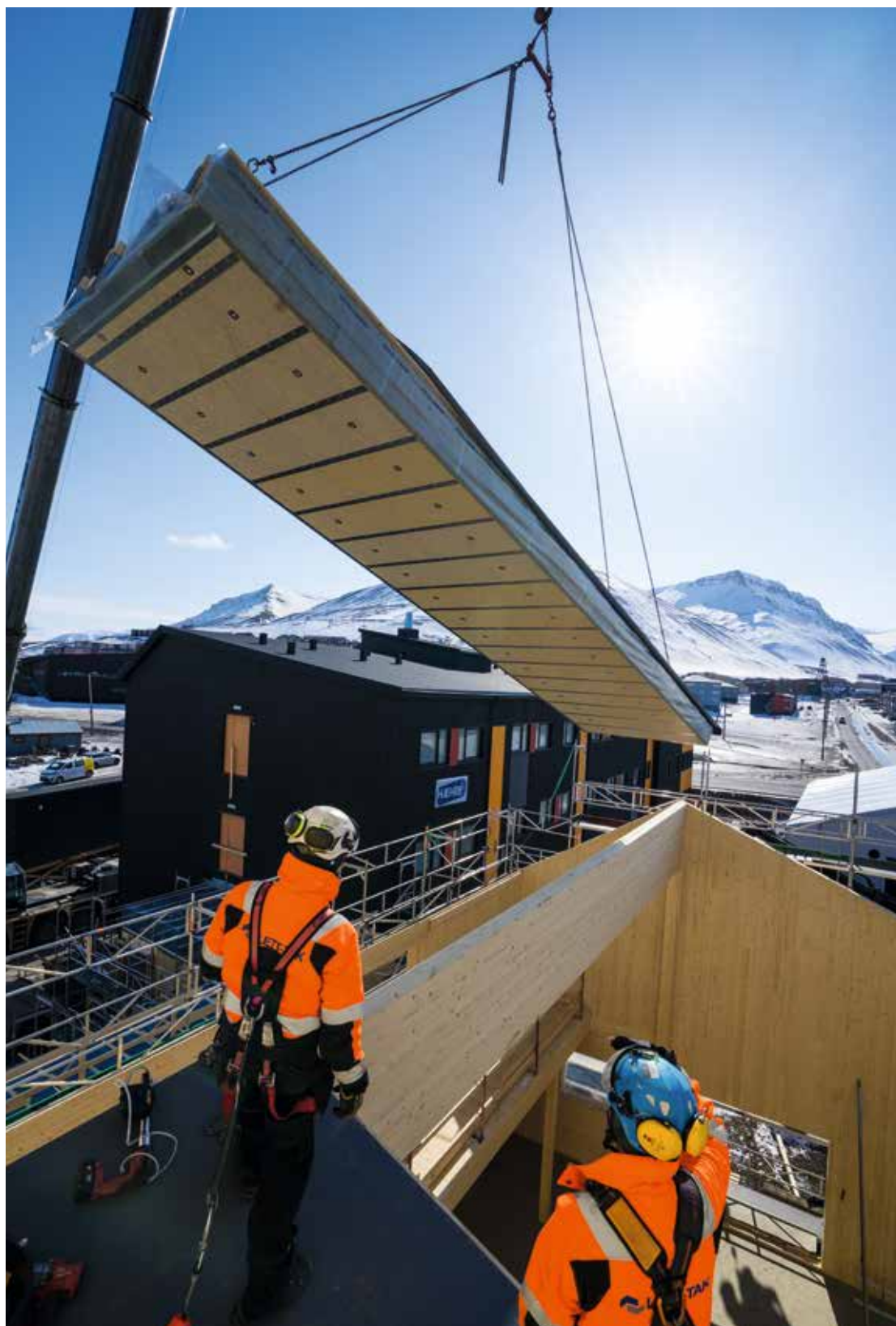
Et av massivtrelementene heises på plass. Foto: Martin Nerhus Øen, Hæhre Arctic
