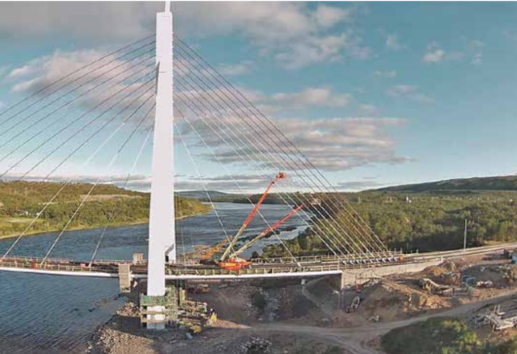
RETT FØR OVERLEVERING: 14. juli var malingsarbeidet godt i gang og 500 tonn asfalt var lagt på brudekket. Foto: Byggekamera.no/Statens vegvesen
