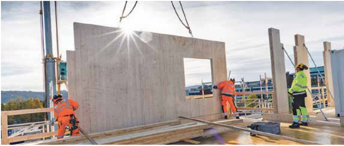
MASSIVTRE: Et nytt veggelement løftes på plass ved Alta omsorgssenter. Foto: Ørjan Bertelsen/Peab
