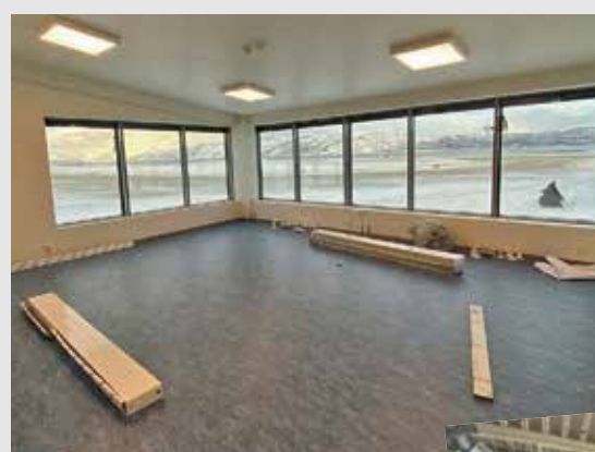
TAR FORM : Det nærmer seg slutten av byggeperioden og oppholdsrommet i 2. etasje begynner å bli ferdig.
