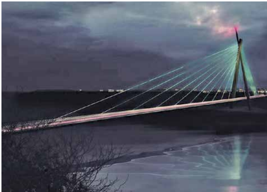
SPEKTAKULÆRT: Ca. 1200 lys med individuell styring er montert i rekkverket på nye Tana bru. Dermed er det mulig å variere med ulike lysprogrammer og farger gjennom døgnet og året. Grafikk: Zenisk
