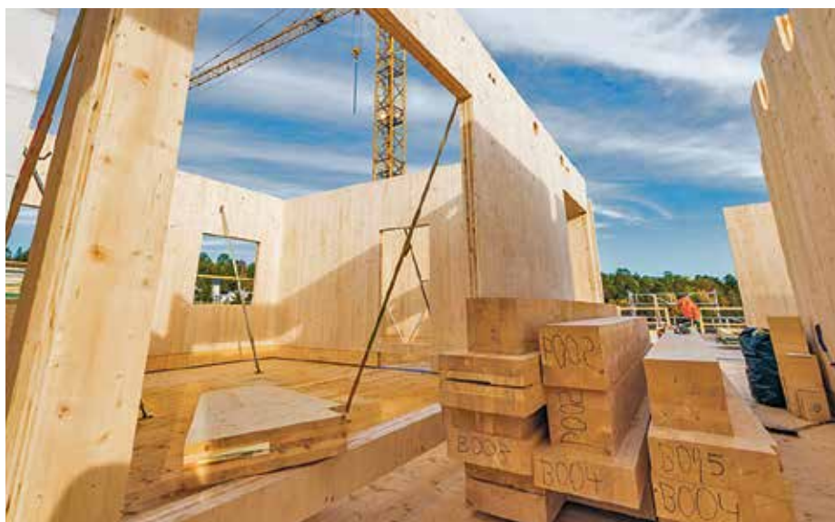
PLANLEGGING: Dragere klar for montering. Ved bygging i massivtre leveres alle materialer som prefabrikkerte elementer- og på byggeplassen må alt stemme. God planlegging er avgjørende. Foto: Ørjan Bertelsen/Peab
