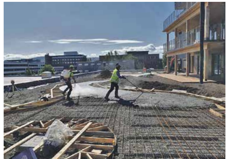
GULVSTØP: Fagfolk fra K.S.K Bygg i gang med støping av et av mange gulv ved senteret. Foto: K.S.K Bygg AS.
