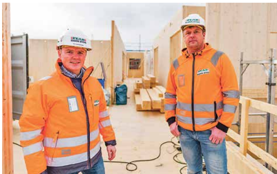
FORNØYD: Massivtre gir også mange fordeler for dem som bygger, mener prosjektleder Roy Gunnar Berg i Peab Bjørn Bygg. Her sammen med formann Kjetil Farstad. Foto: Ørjan Bertelsen/Peab
