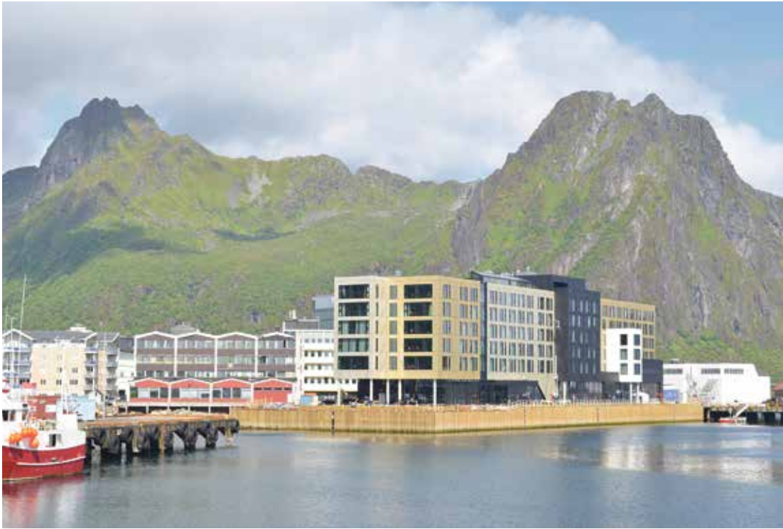
MELLOM HAV OG FJELL: Bildet er tatt noen uker før ferdigstilling. Hotellet er omkranset av alle elementer man forbinder med turistmagneten Lofoten. Foto: Jonas Ellingsen
