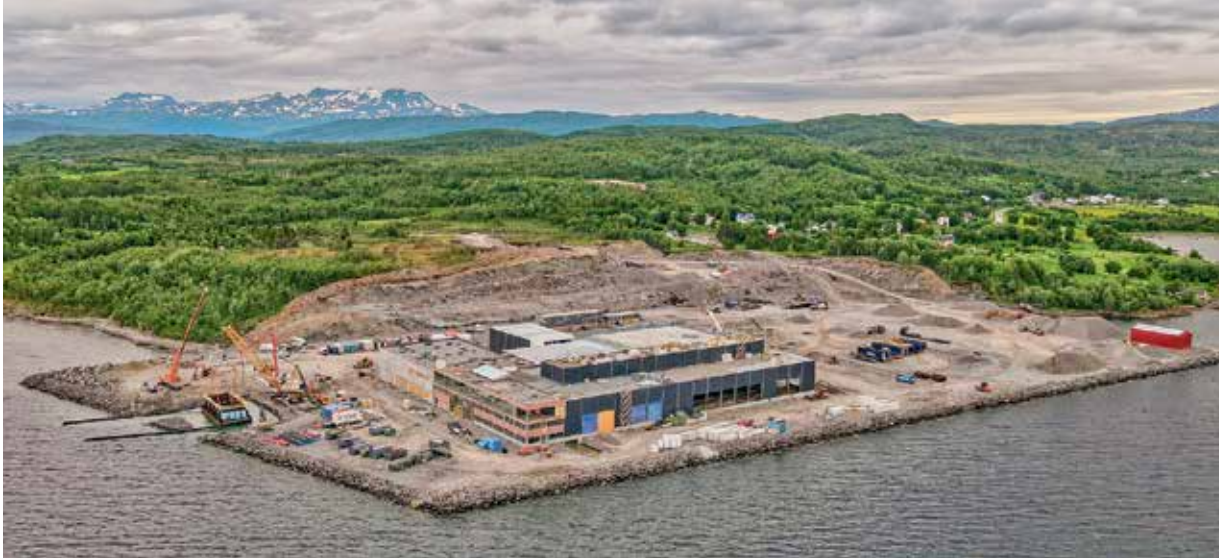
TRAVEL BYGGEPLASS: Mange lokale underleverandører deltok på InnovaNor. På det meste var 200 arbeidere i sving på byggeplassen. Foto: SalMar
