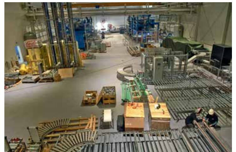
ANLEGG: Mye arbeid ble nedlagt før den nye fabrikk kunne settes i drift i fjor høst. Foto: Rune Ottarsen
