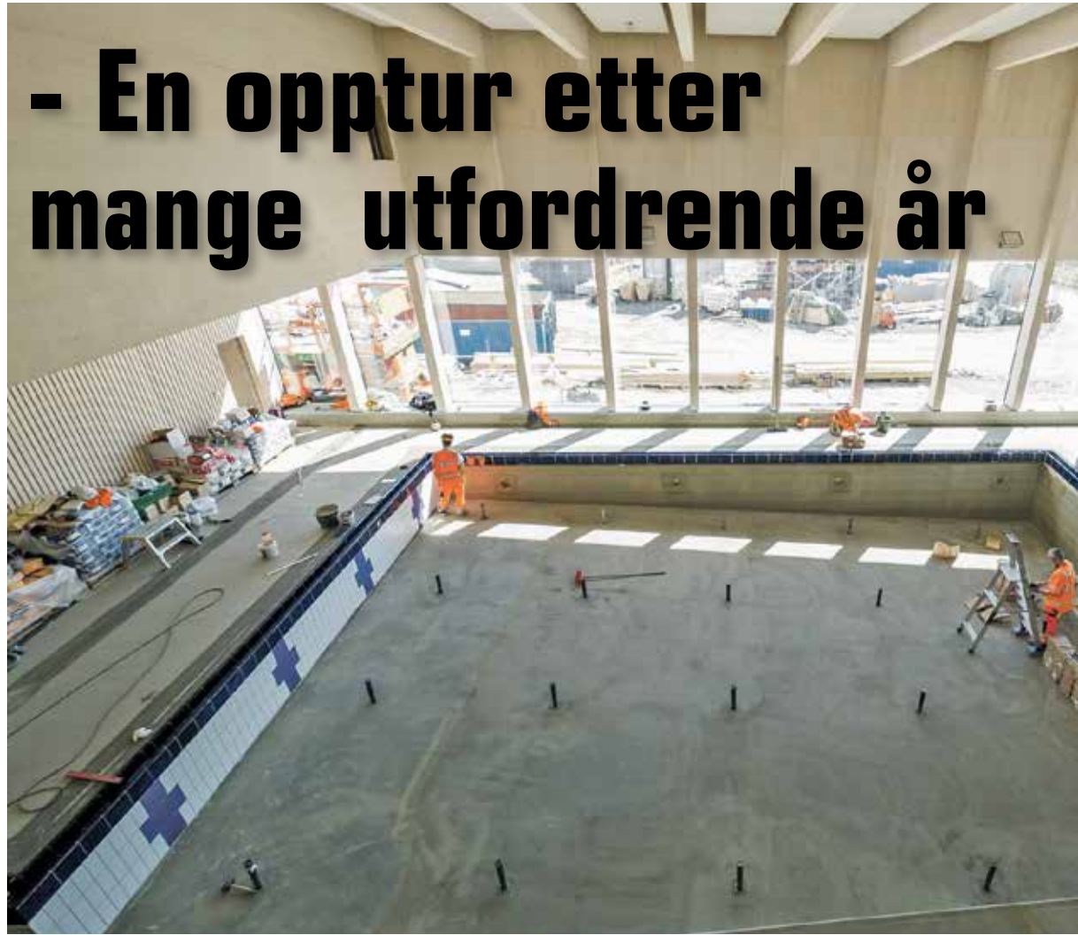
FLEBRUKSHALL: Fra arbeidene med bassenget i den nye flerbrukshallen. Foto: Ørjan Marakatt Bertelsen
