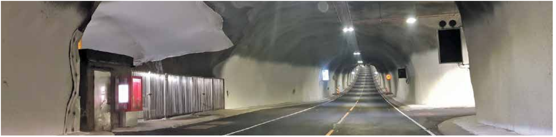
Ibestadsamfunnet får en moderne tunnel, der belysningen er en helt annen enn i den gamle. Foto: BMO Tunnelsikring AS
