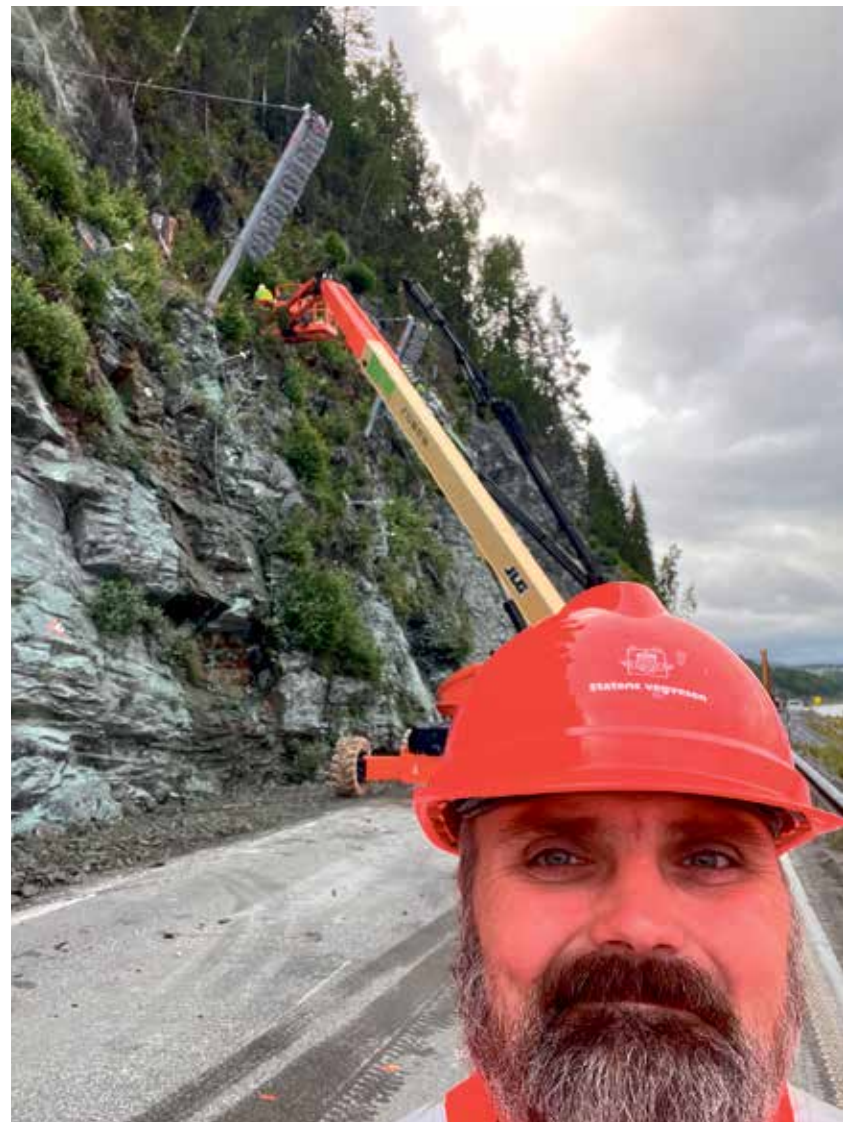
Bjørn Laksforsmo på befaring på et av vegvesenets mange skred-sikringsprosjekt. Foto: Privat
