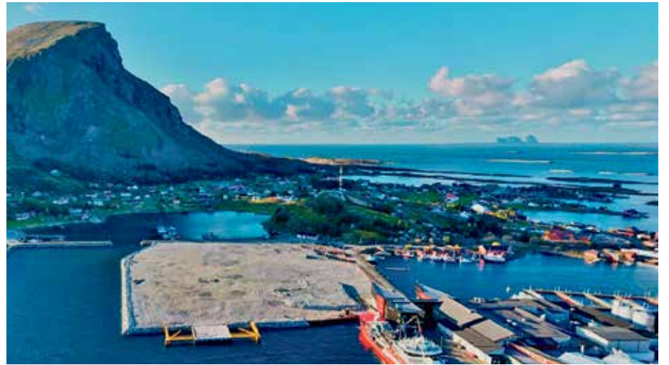
BYGGEKLAR TOMT: Tomta på Naustholmen er i stor grad klargjort for bygging av det nye prosessanlegget. Foto: Nova Sea
