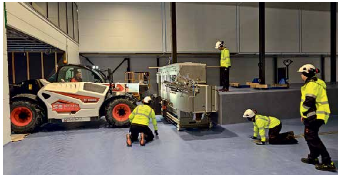
I disse dager foregår det montering av sløyemaskiner og annet produksjonsutstyr. Foto: Holmøy
