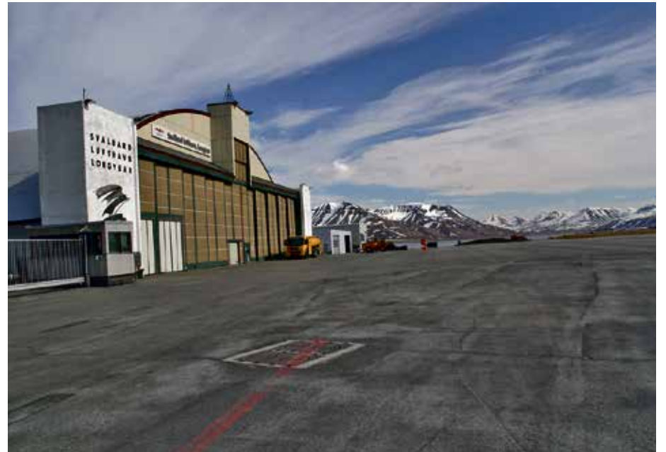
Miljødirektoratet har satt en frist til 1. januar 2025. Da skal oppryddingsarbeidet være ferdig. I løpet av 2023 regner ledelsen ved Svalbard Lufthavn med at halvparten av jobben er gjort og at halvparten av massene er fjernet. Det er for øvrig ikke bare flyplassen på Svalbard som har fått et slikt pålegg. Foto: Hylgeriak - commons.wikimedia.jpg
