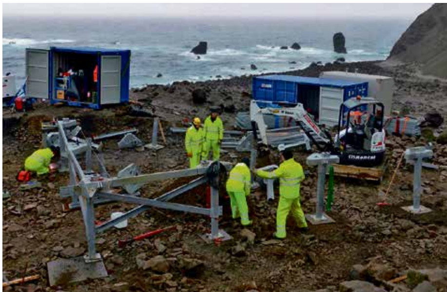
KREVENDE OPPDRAG: LNS i gang med å sette opp fundament for en forskningsstasjon på Bouvetøya i Sørishavet. Den er kjent som verdens mest utilgjengelige øy, og utgjør toppen av en vulkan. Foto: LNS
