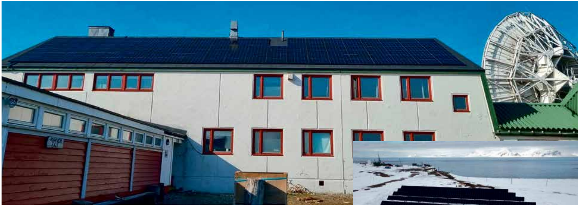
Solceller på taket på Hovedstasjonen på Isfjord Radio. Foto Store Norske
