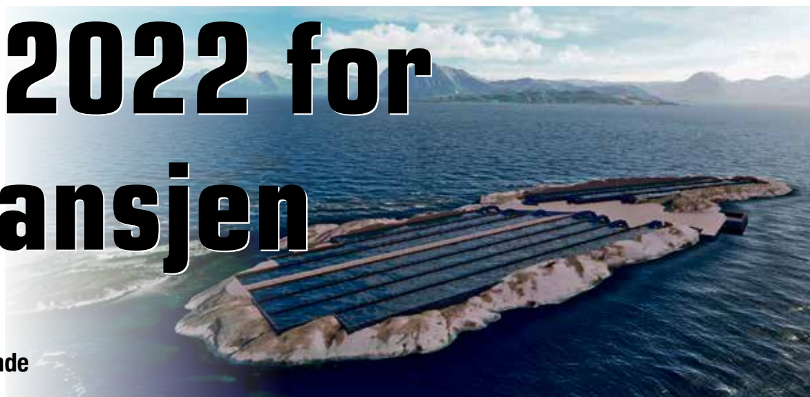
Elektro Bodø AS leverer total-løsning på automatisering, instrumentering, IKT-/telekommunikasjon og kraftdistribusjon til anlegget som Gigante Salmon har under bygging i Rødøy kommune. Foto: Gigante Salmon
