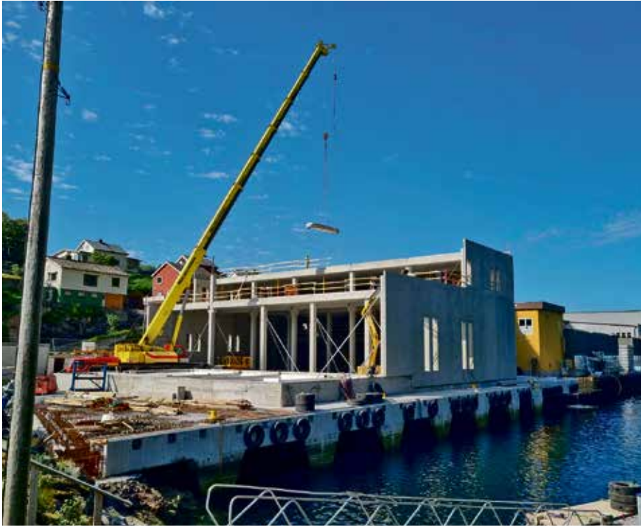
Montering av betongelementer. Foto: Tromsbygg Entreprenør AS
