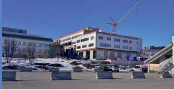
Bilde fra byggeprosessen, som har tatt to år. Foto: Ishavsbyen VGS
